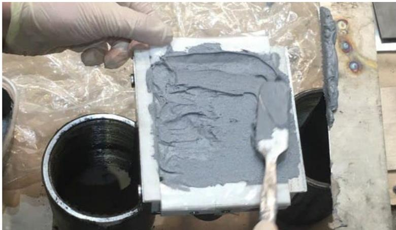
Рисунок 1.18 – Нанесение клеевой композиции в зажим для пластыря
